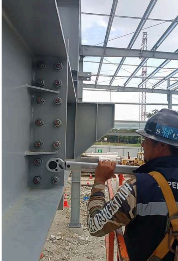
Ensayo de Torque en Placas de Anclajes
