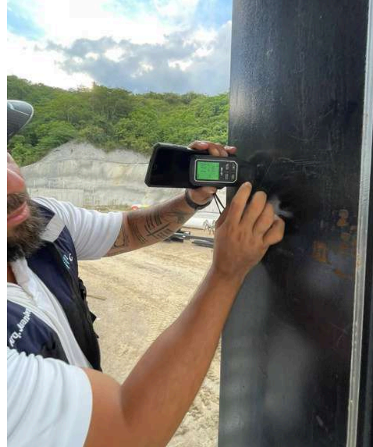
Ensayo de Espesor de Pintura Anticorrosiva
